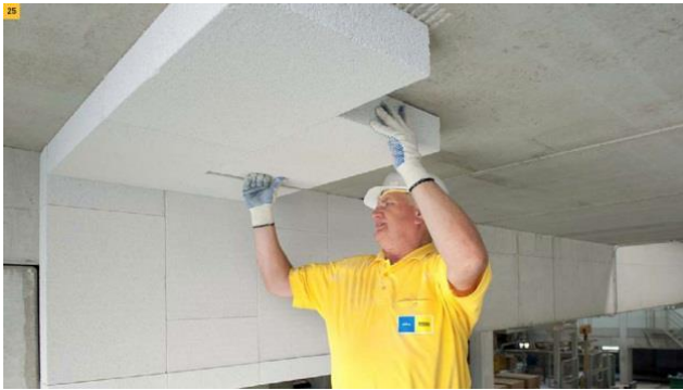
Obr. Vnitřní zateplení Ytong Multipor
